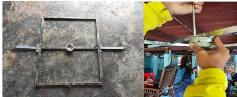
ภาพที่ 8 ฐานรองแผงโซลาร์เซลล์ และหัวบอลหมุนใต้แผงโซลาร์เซลล์
