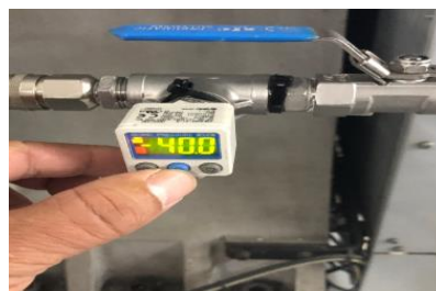
ภาพที่ 7 ทำการปรับตั้งค่าของสวิตช์ควบคุมความดัน
