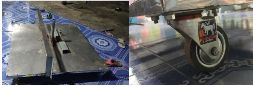
ภาพที่ 7 ประกอบและเชื่อมฐานพื้นล่าง และล้อยูรีเทน
