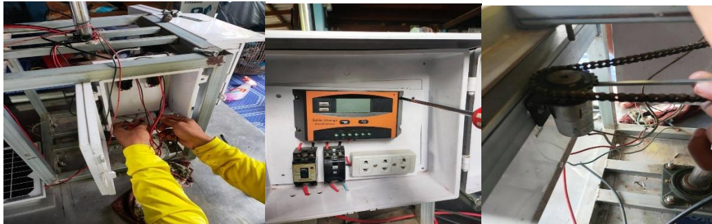
ภาพที่ 11 เดินสายวงจรทั้งระบบ ตัวคอนโทรลชาร์จเจอร์และชุดมอเตอร์หมุนเสา
