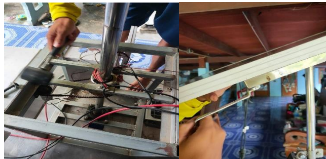
ภาพที่ 9 ติดตั้งโครงจับเสา และแผงโซลาร์เซลล์ 100 W
