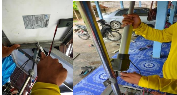
ภาพที่ 10 ติดแผงป้องกัน ด้านข้างแผงใหญ่และมอเตอร์ลิเนียร์
